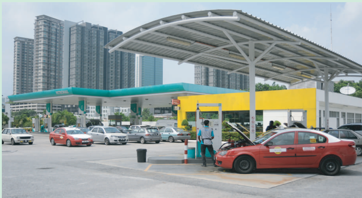
Stesen minyak PETRONAS merupakan stesen minyak yang menyediakan kemudahan pam gas asli (NGV) di Malaysia
