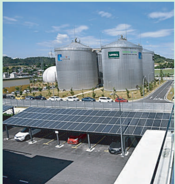
Loji Kumbahan Pantai 2 STP yang terbesar di Malaysia terletak di Pantai Dalam, Kuala Lumpur
