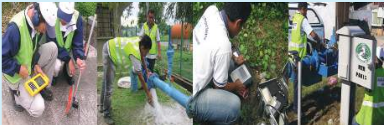
Pemeriksaan dan penggantian paip-paip lama sedang dijalankan
