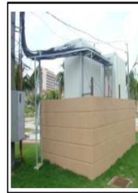
Pendawaian terbuka pada papan iklan seperti ini tidak akan dibenarkan. Selain mencacatkan pemandangan ia akan menimbulkan isu keselamatan bagi orang awam.
